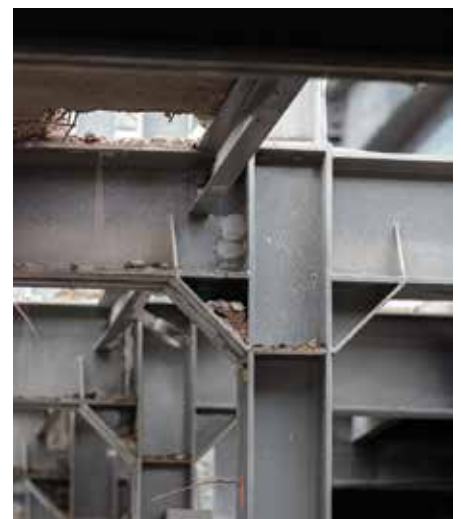
Bestaande bouw en sloop.
