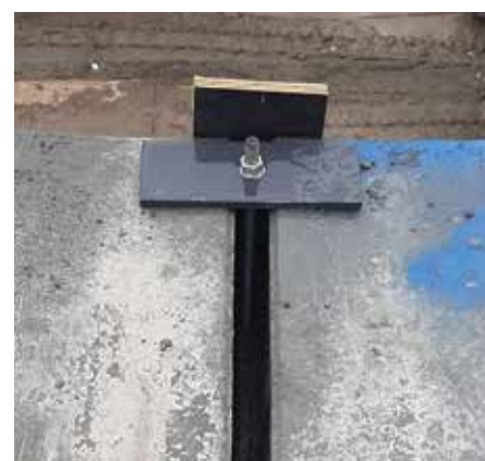
Demontabiliteit via draaieind en (volg)plaat (p. 28).
