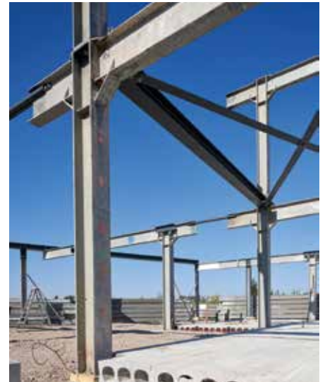
Nieuw staal voor horizontale (wind)krachten.
