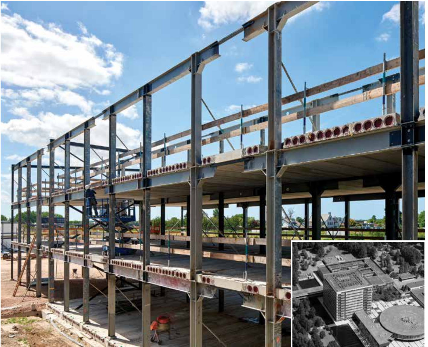
Opbouw van Biopartner 5. De staalconstructie van de drie bovenste verdiepingen van het naburige Gorlaeus-gebouw (inzet) is tegen schrootprijs 'gedoneerd'.
