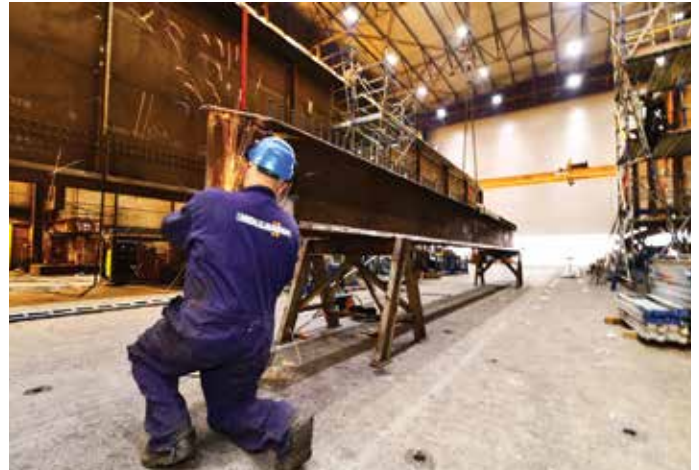
Voorbereiden dwarsdrager voor inbouwen in brugdek.
