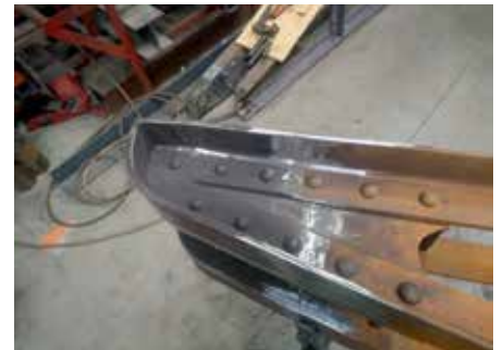
5. Dakrand met geklonken plaat- en hoekprofielen.
