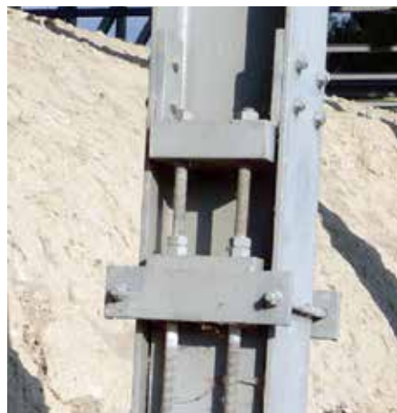
2. Bestaande kolom met uitschuifstelsel.
