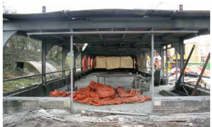
Gestript, schoongemaakt, opnieuw verzinkt en herbouwd.
