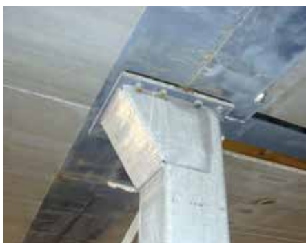
Uitgebouwde kolom bij dubbele staal-betonligger ter plaatse van een dilatatie.
