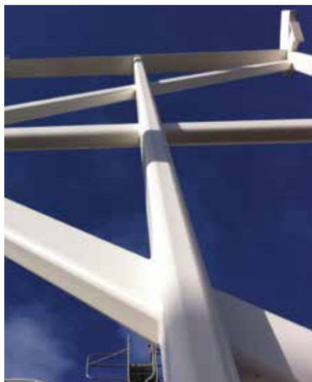
Kokers met een grote staaldikte hebben grote afrondingsstralen. Dat kan zich aftekenen in het beeld.
