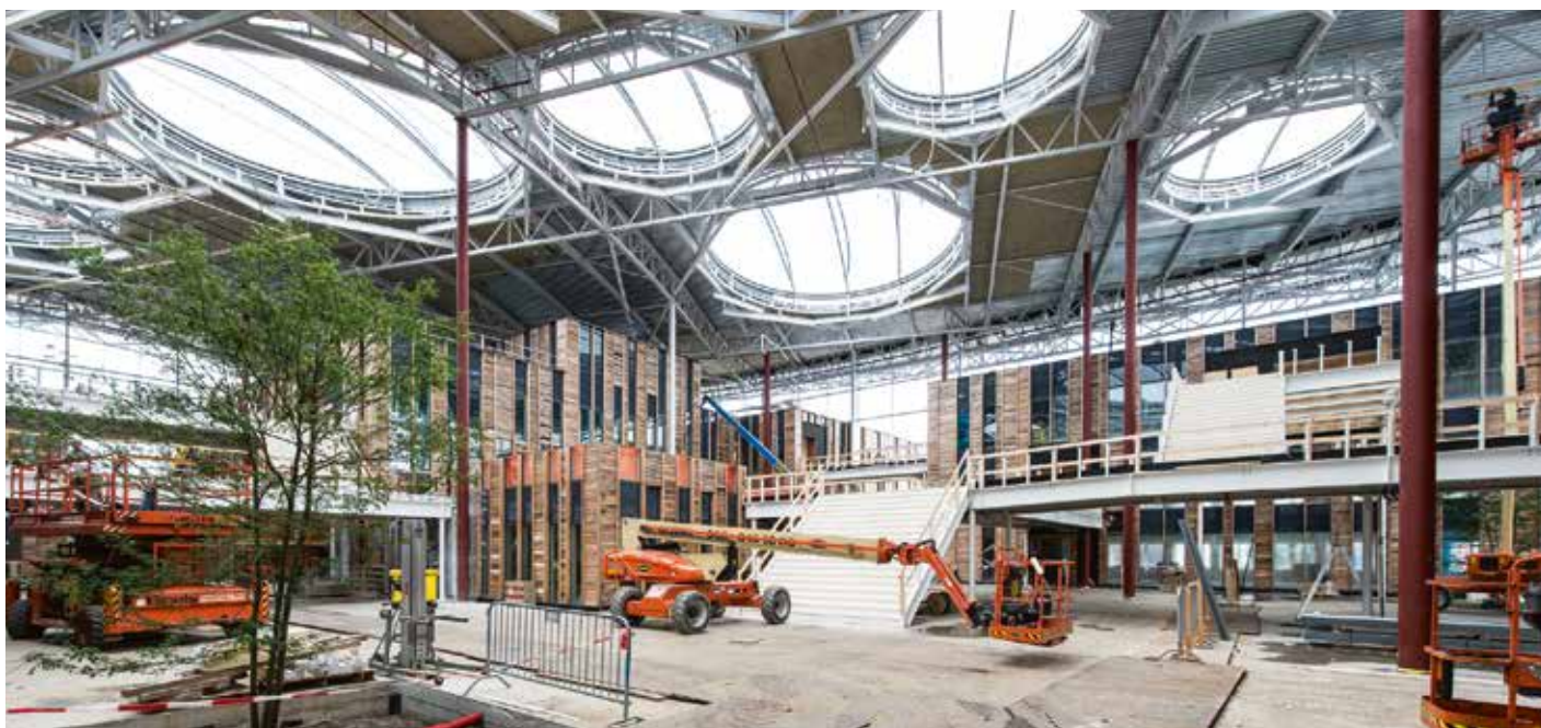
Het dak is 8700 m 2 groot. Dertig stalen buiskolommen dragen de vakwerken. Hier en daar zijn betonnen kolommen toegevoegd op de bestaande gebouwen.
