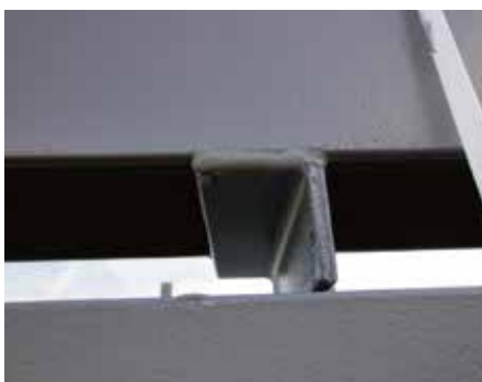
Overmaat coating door verschillende spuitrichtingen.
