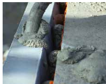
Aanbrengen van de betonvulling in het staalprofiel.
