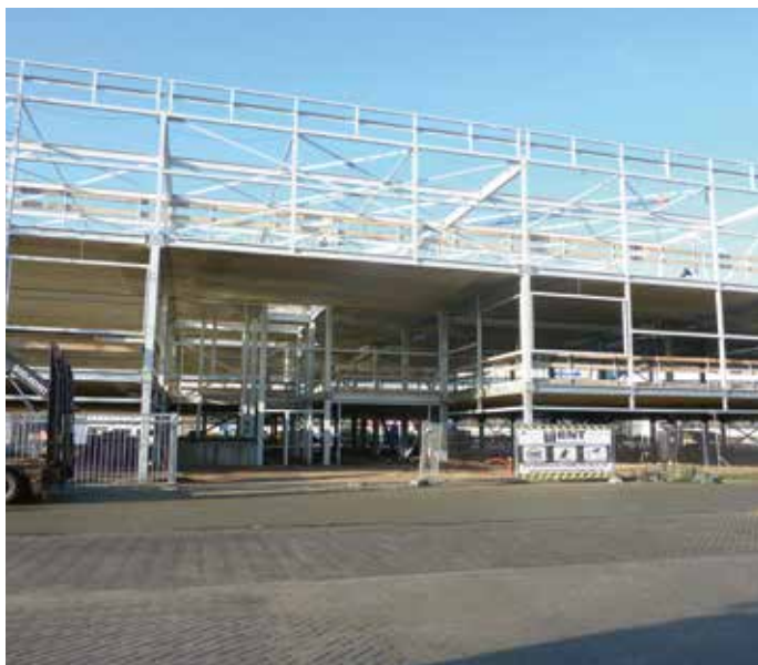
Expositiezijde met toegang naar de parkeerlaag.
