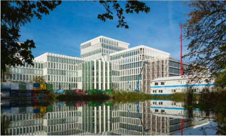
Renovatiegevel van het ASR-gebouw en nieuwbouw van het AkzoNobel Center, beide nog in uitvoering.
