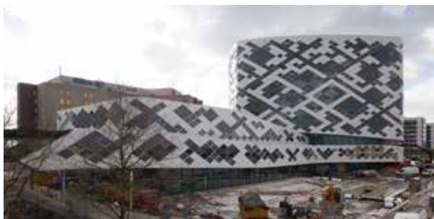
Het laagbouwdeel en het kubusvormige 'beddenhuis', met onderin de incisie van de architect.
