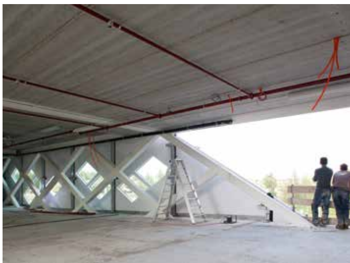
De vakwerken in de noordzijde van het beddenhuis volgen hetzelfde ruitpatroon van de elementengevel (composiet).
