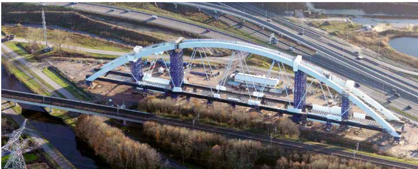
Tijdelijke bypass van de spoorlijn parallel aan de bestaande spoorbrug.
