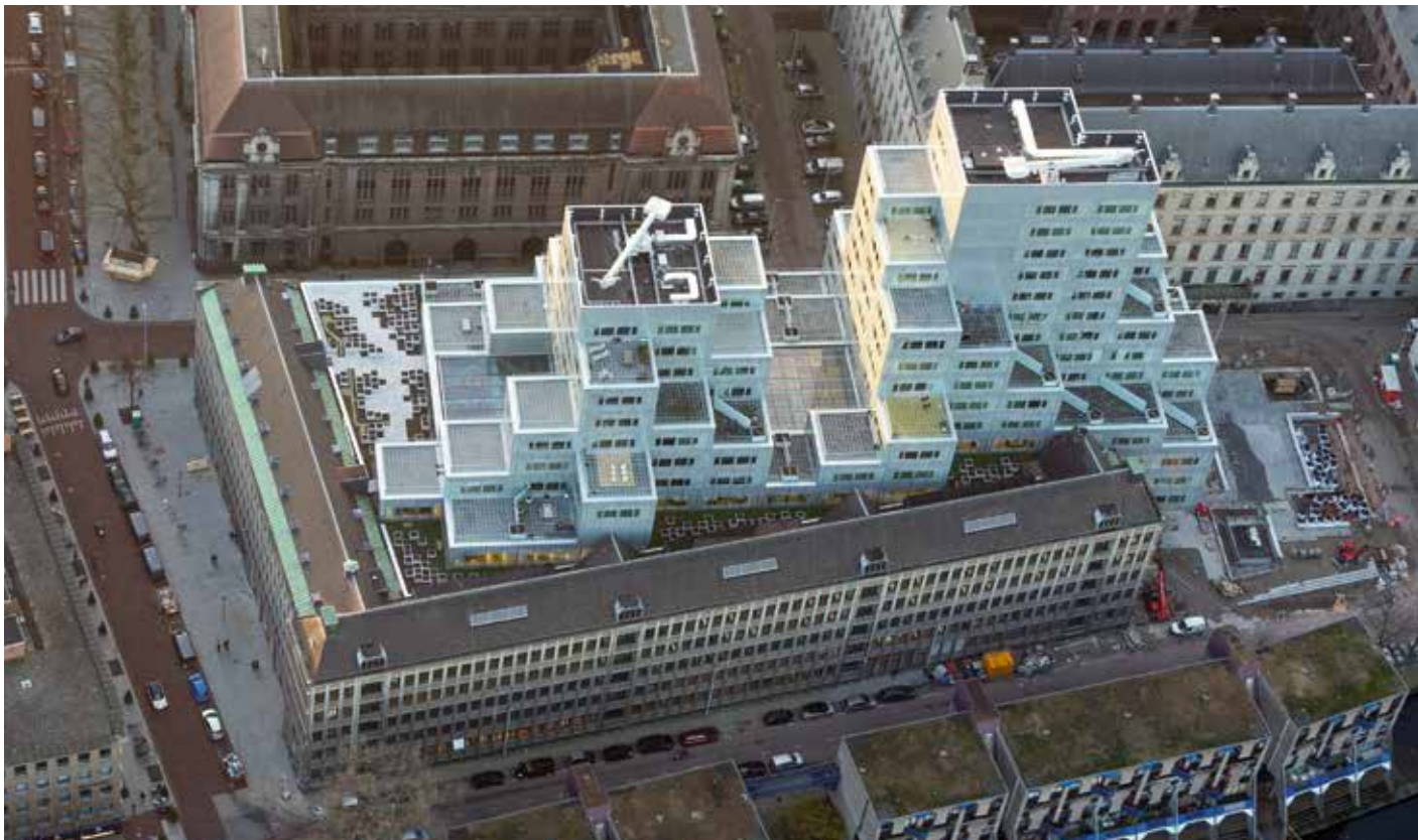
De 'pixelberg'. De constructie (3850 ton staal) steunt enkel op kolommen in de twee kernen voor liften en trappenhuisen.
